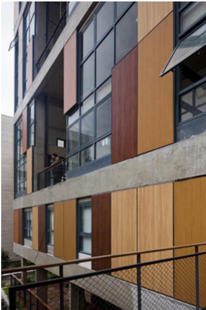
Figura 24: Foto do embasamento para passagem de instalações.
