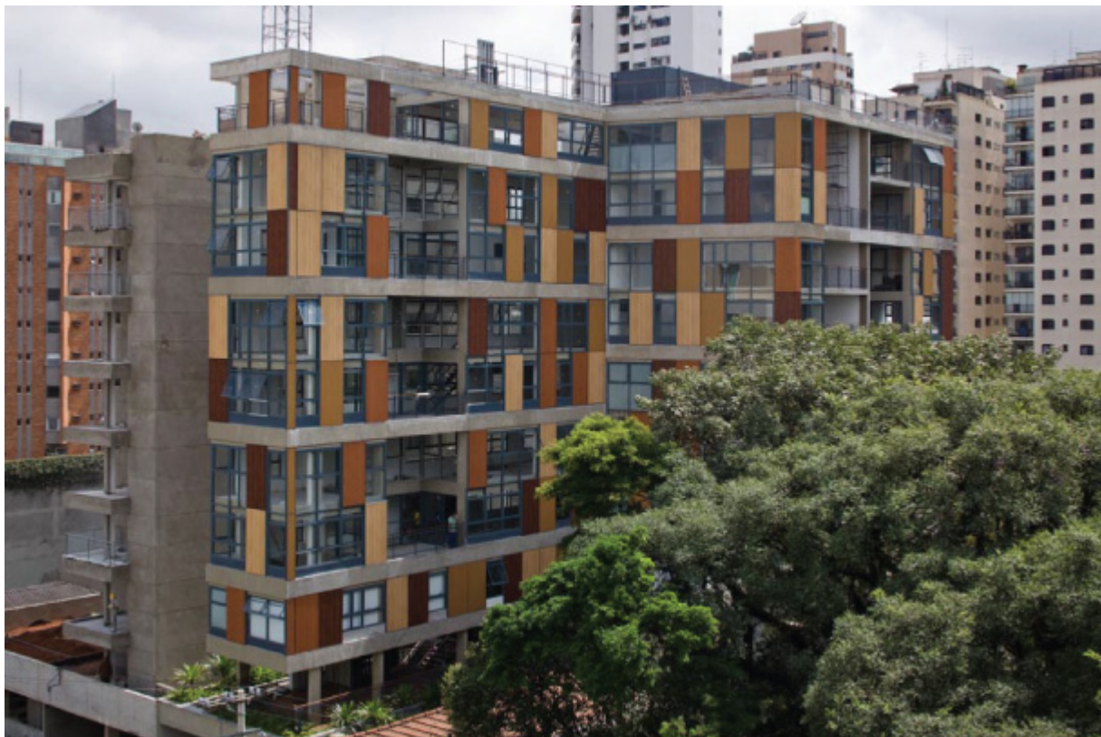
Figura 5: Foto da elevação lateral direita.
